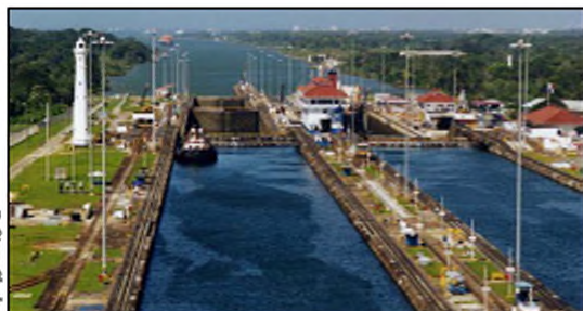
Рис. 2. Панамський канал — одна з найбільших інженерних споруд у світі. Довжина каналу — 81 км, глибина — 12 м. Він з'єднує Атлантичний океан із Тихим. До відкриття каналу шлях з одного океану до іншого дорівнював 12 тис. км навколо Південної Америки. Сьогодні каналом щорічно проходить 14 тис. кораблів.
