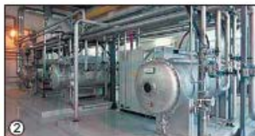
Рис. 29.4. 1. Приміщення сучасної станції водопідготовки. 2. Озонаторна
