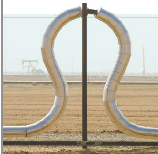
Рис. 11.5. Щоб трубопроводи для передачі гарячої води не пошкоджувалися внаслідок зміни температури, конструктори створюють розширювальну петлю
