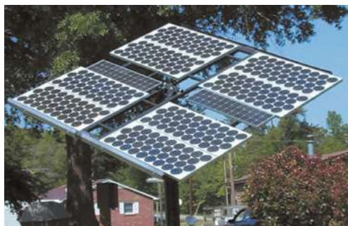
Рис. 31.3. Напівпровідникові кристали використовують для виготовлення сонячних батарей
